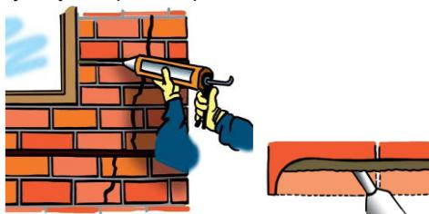
3) Malta ResiBond MC se rozmíchá přímo v originálním kbelíku šnekovým nástavcem na vrtačku, smícháním suché a tekuté složky v balení - **bez dalších příměsí!**, po 5 minutách se znova promíchá a plní do předem navlhčené aplikační pistole.
