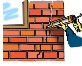
9) Trhlinu vyplním pevnostní maltou nebo maltou ResiBond MT.
