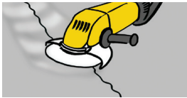
Obr. 1 Broušení a vyčištění povrchu trhliny
