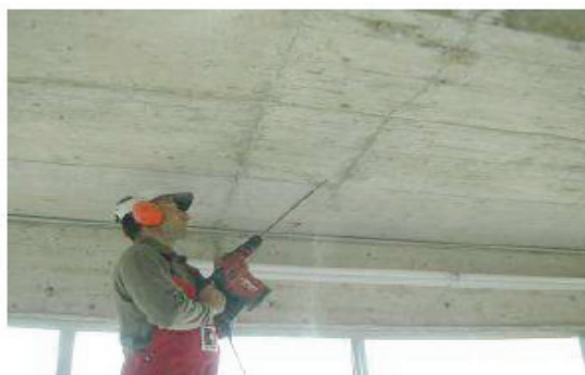
Obr. 2 Vrtání otvorů pro pakry
