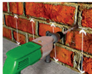
Vyvrtní otvorů ve výškové vzdálenosti.
