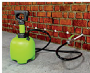
Injektáž krému do vrtu.
