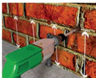
Vyvrtní otvorů ve výškové vzdálenosti.
