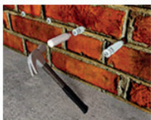
Osazení injektážních pakrů.
