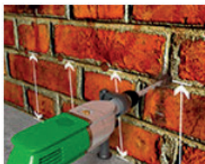
Vyrtání otvorů ve výškové vzdálenosti.
