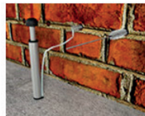
Čištění otvorů.
