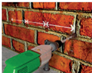
Vyrtání otvorů v osové vzdálenosti.
