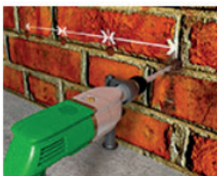
Vyvrtní otvorů v osové vzdálenosti.
