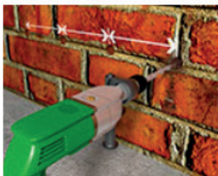
Vyvrtní otvorů v osové vzdálenosti.
